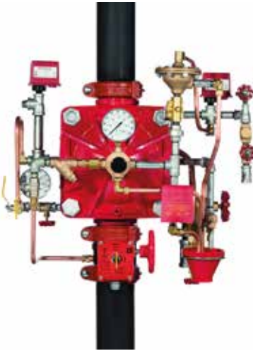
Ön Tepkimeli ve Baskın Alarm Vanaları
